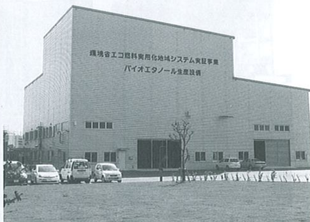
▼昨年完成したエタノール製造プラント
