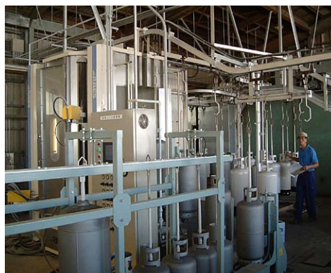
LPガス容器耐圧検査場
