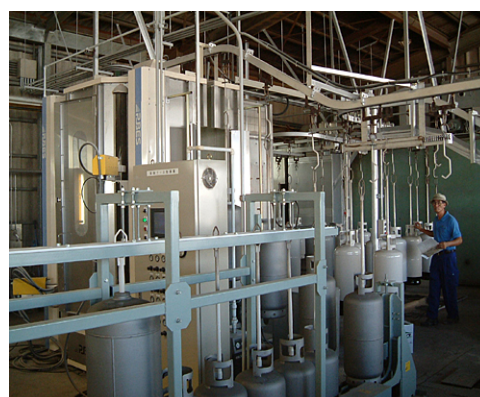
LPガス容器耐圧検査場
